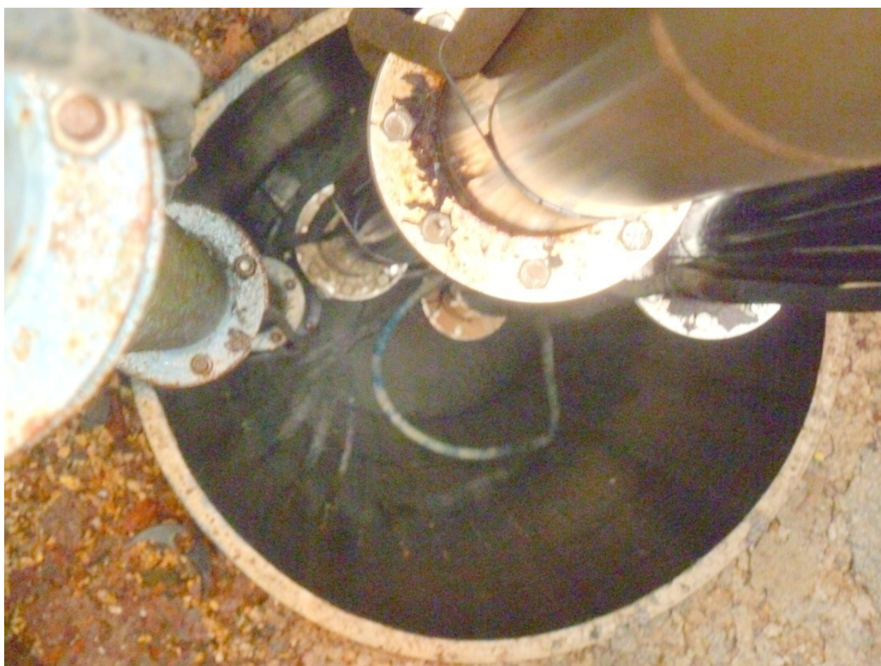
Figure 13 : puits après ouverture et vue du haut du tubage en acier crépé
