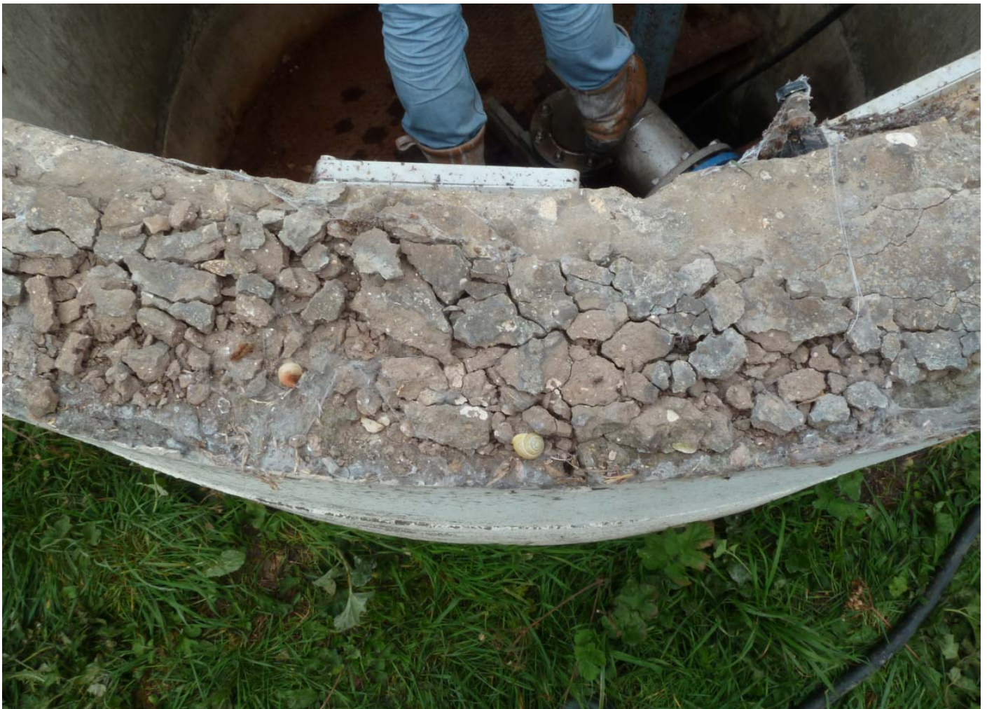
Figure 2 : partie aérienne de la tête du puits.
