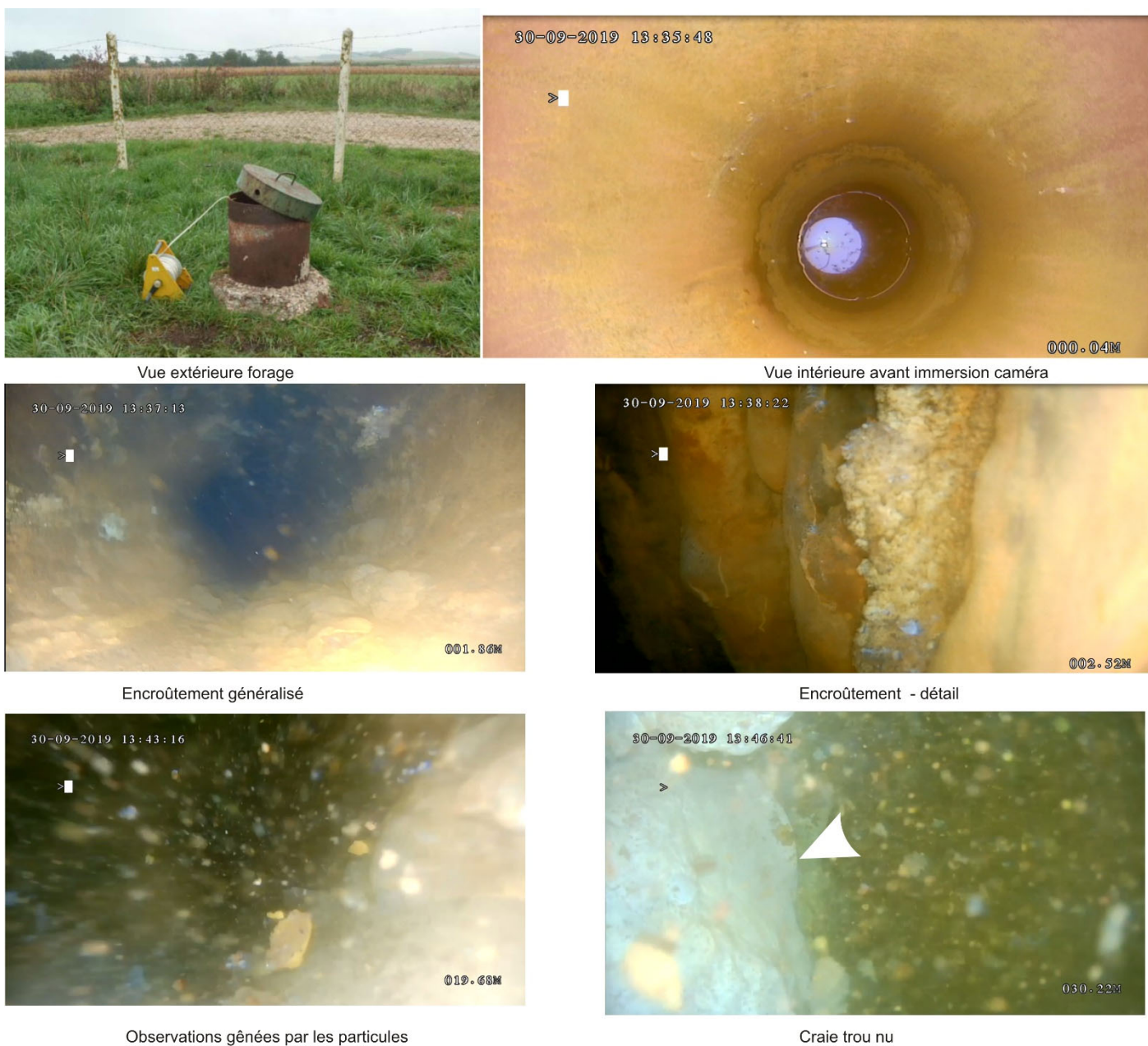
Figure 10 : forage de reconnaissance – planche photographique de l'inspection.
