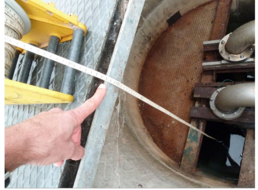
Vue sur avant-puits
