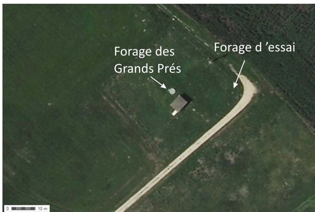
Figure 9 : localisation des puits aux abords du forage.
